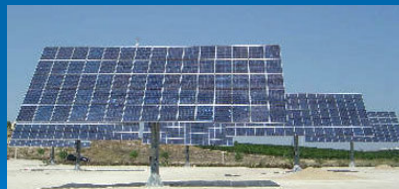
Σχήμα 1: Φωτοβολταϊκά πλαίσια σε trackers
