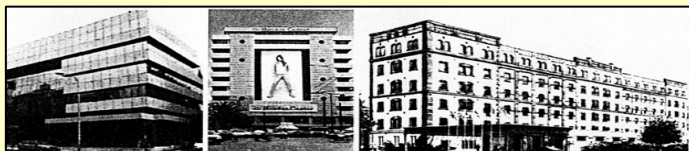
Πρώτο αριστερά, το νέο κτίριο γραφείων στη Μικαλακοπούλου, στο κέντρο το πολυκατάστημα Honda Center στην Ομόνοια και δίπλα το υπό κατασκευή TriVillage Development στις εγκαταστάσεις των Μύλων Αλλαντίων.
