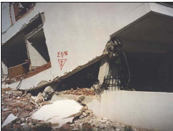
Σχ.20: Κατάρρευση λόγω θραύσης υποστηλωμάτων πυλωτής
