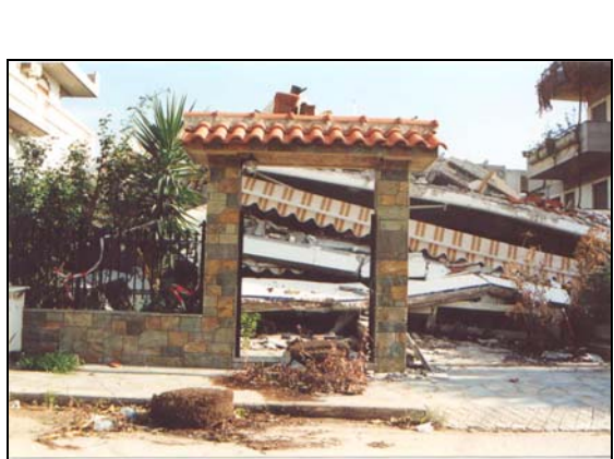
Σχ.21: Κατάρρευση λόγω ολικής θραύσης υποστηλωμάτων
