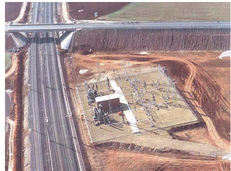
Υποσταθμός τροφοδοσίας έλξης 25kV 50Hz της γραμμής υψηλών ταχυτήτων Μαδρίτης - Σεβίλλης
